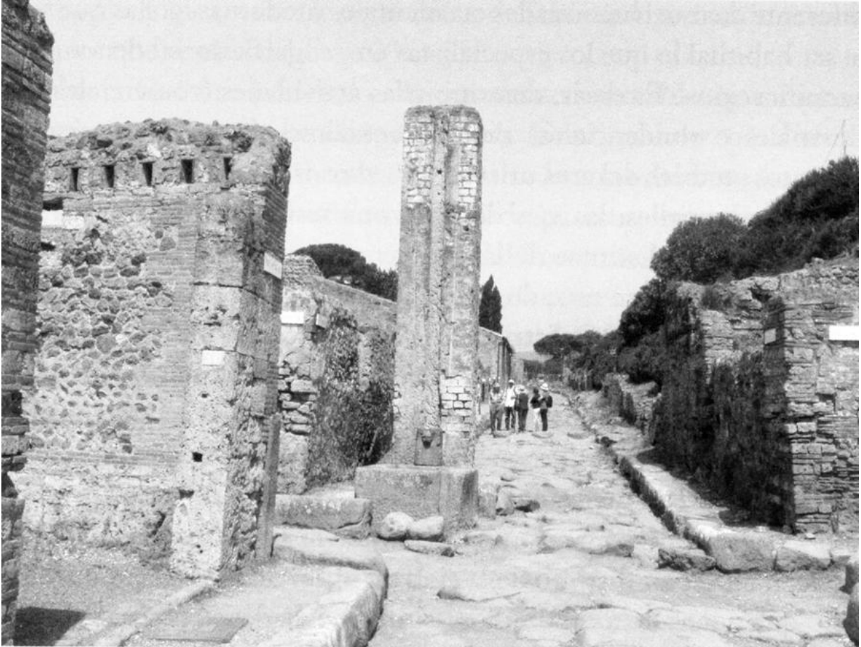
FIGURA 22. En este cruce de calles encontramos una fuente pública y una de las torres del agua existentes en la ciudad (aproximadamente doce). El agua procedente del «castillo del agua» llegaba a un depósito situado en la parte superior de cada torre, y luego era distribuida a las fincas vecinas. La finalidad de estas construcciones era reducir la presión del agua, que, de lo contrario, habría bajado del castellum con demasiada fuerza.
