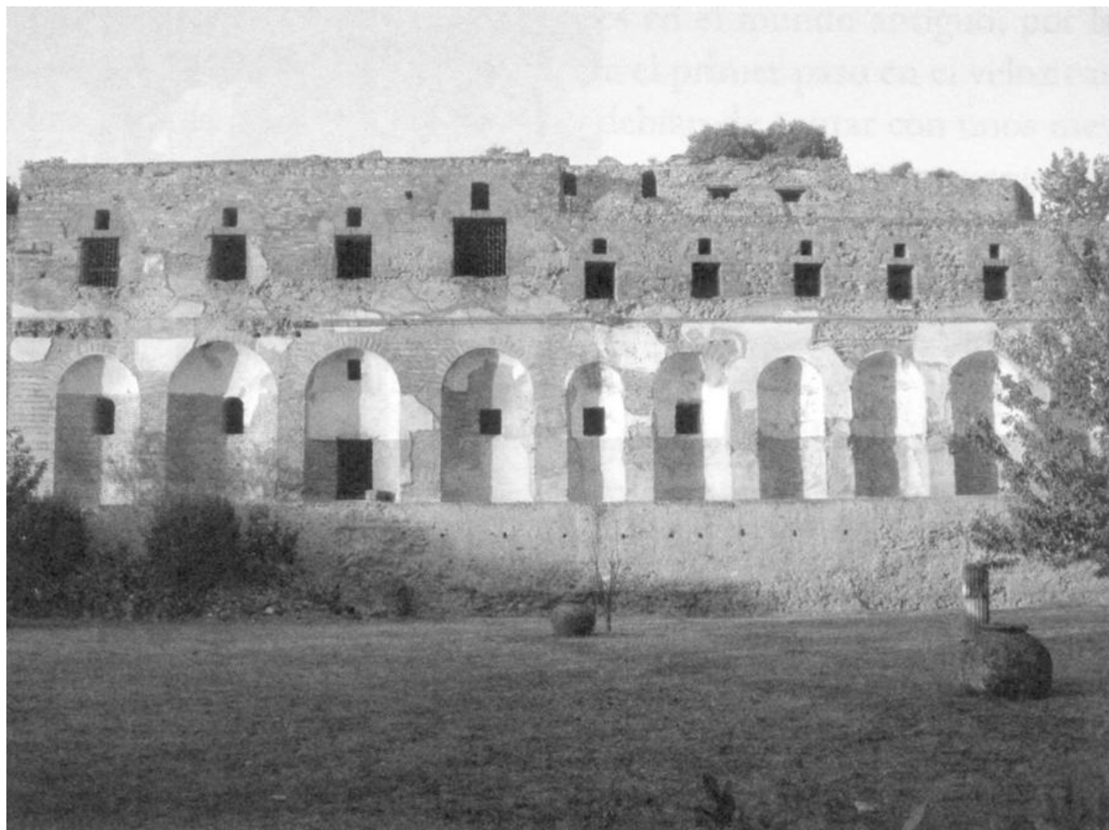
FIGURA 38. Unos baños con vistas al río: las Termas del Sarno. El establecimiento balneario estaba en el piso bajo. Las plantas superiores estaban ocupadas por apartamentos residenciales.
