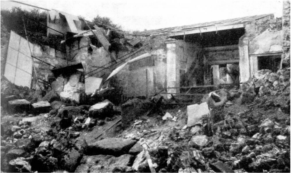
FIGURA 9. El bombardeo de los Aliados en 1943 causó daños terribles en Pompeya, y destruyó muchos edificios importantes. Esta fotografía muestra el estado en que quedó la Casa de Trebio Valente tras las incursiones aéreas. Muchos de los edificios bombardeados fueron tan primorosamente reconstruidos después de la guerra que a nadie se le ocurriría pensar que sufrieron una segunda destrucción intencionada.
