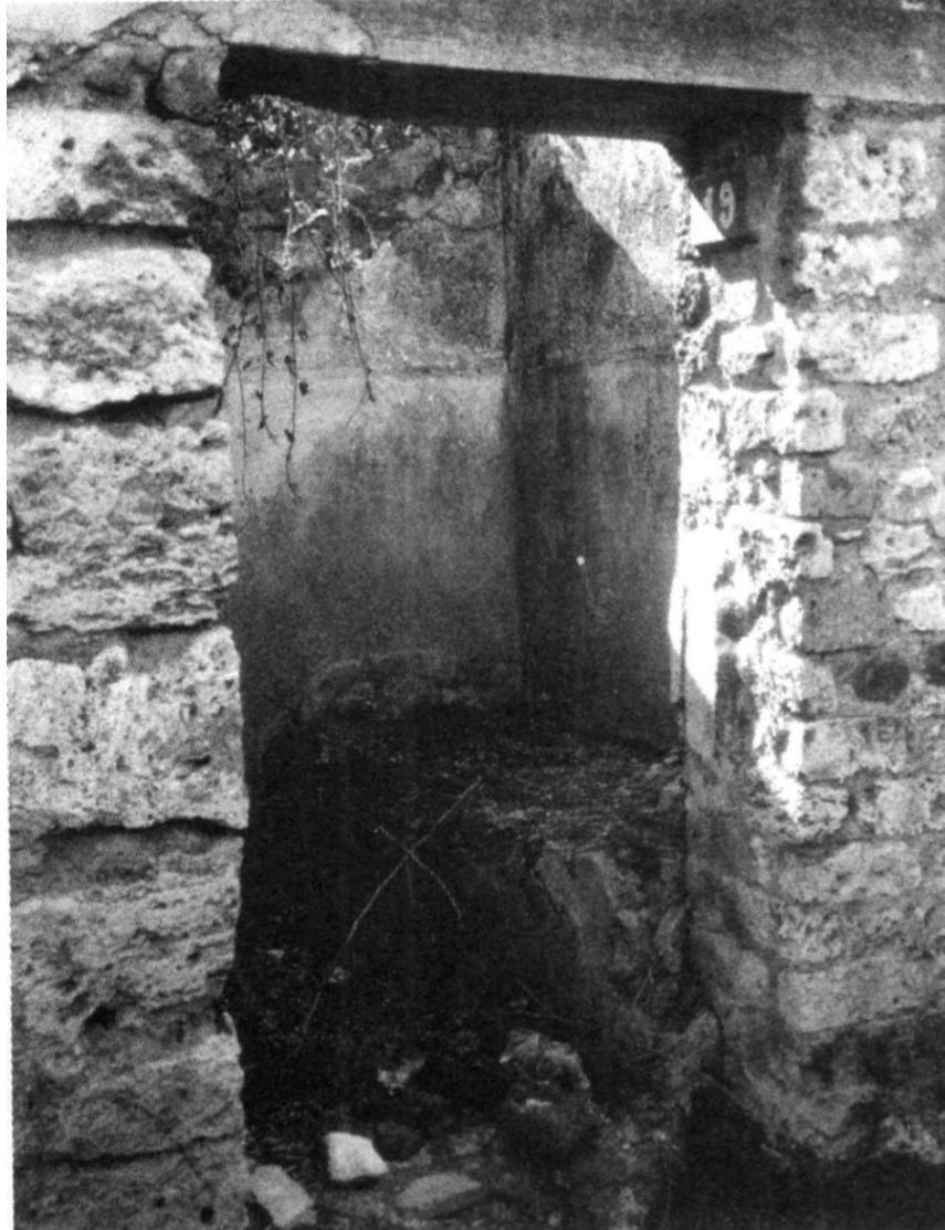
FIGURA 37. Vivienda de una sola habitación abandonada, provista simplemente de una cama de fábrica. ¿Se trata del cubículo de una prostituta? ¿O era la forma más barata de alojamiento que había en Pompeya?
